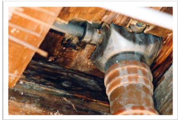
EX 11.2. Afløb til indstøbning er monteret i træ. (Foto: Erik Brandt)
